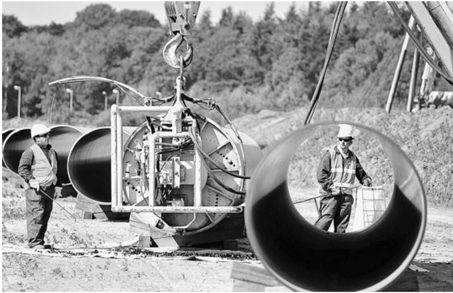
Mehr als 3700 Rohre, jedes 18 Meter lang, werden auf der Strecke zwischen Achim und Rehden verlegt.
