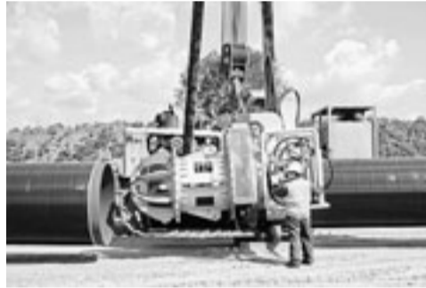
Mit einer riesigen Schleifmaschine reinigen Arbeiter die Rohrenden.
