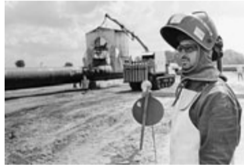
Der Schweißer macht Pause, im Hintergrund versetzt ein Kran das mobile Arbeitszelt.
