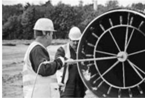
Vor dem Schweißen werden die Rohrenden mit einem Gasbrenner auf 120 Grad erhitzt.
