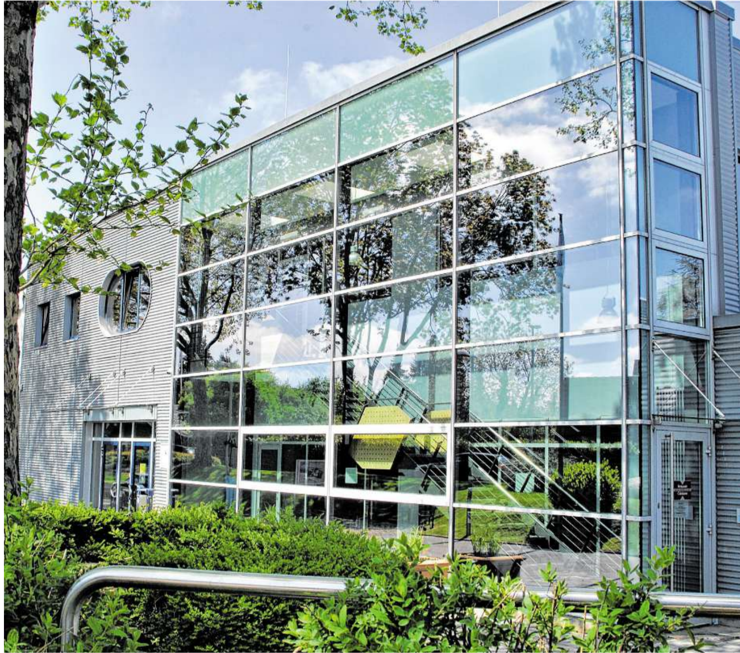
Hinter der gläsernen Fassade des Allwetterbades wird zurzeit gearbeitet. Es werden unter anderem neue Pumpen eingebaut. FOTO: CHRISTIAN VALEK
