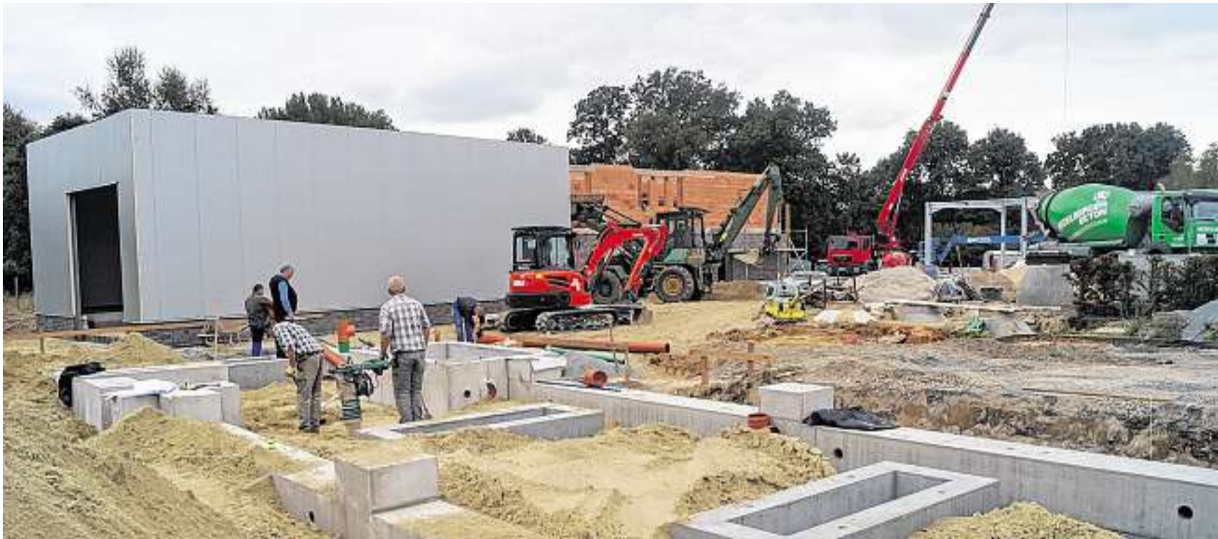
Bau der Waschstraße bei Schmolke: Arbeiter richten die Betonteile ein, sodass sie geradlinig eingebettet werden können. Parallel dazu verlegen Sanitärtechniker Leerrohre, die zum einen der Kabelvernetzung, zum anderen der Wasseraufbereitung dienen sollen. MLS-FOTO: MILENA SCHWOGGE
