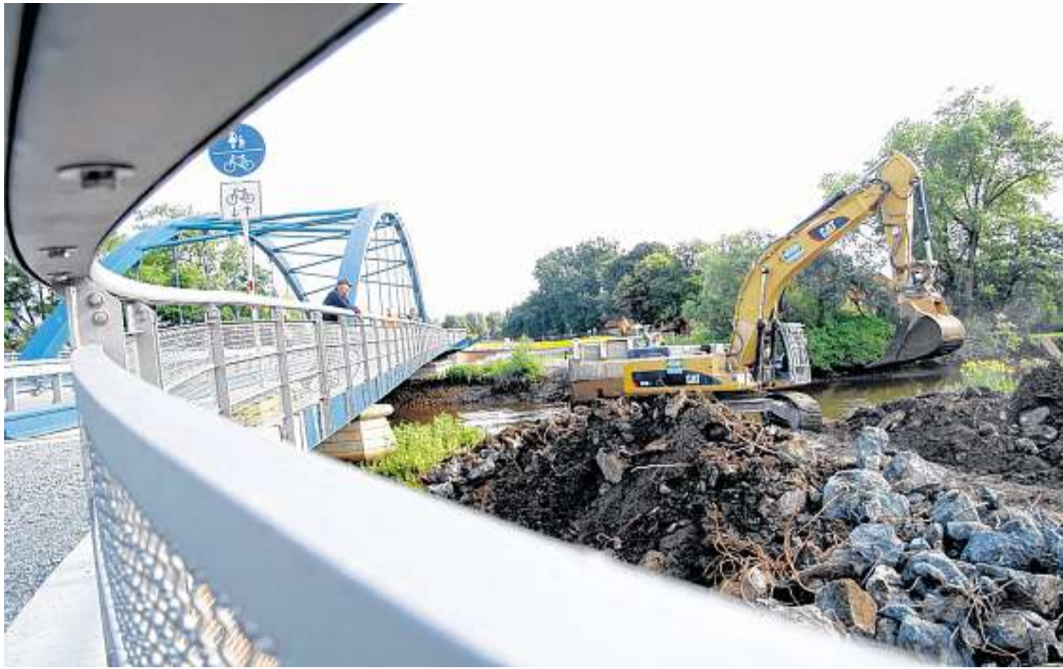
Der Bagger gelangt über eine behelfsmäßige Erdtrasse zu den alten Brückenpfeilern in der Wümme. Dort hat er sich stellenweise bis zu einem Meter tief in den Untergrund des Flussbetts vorgegraben, um die Betonreste dort zu entfernen.
